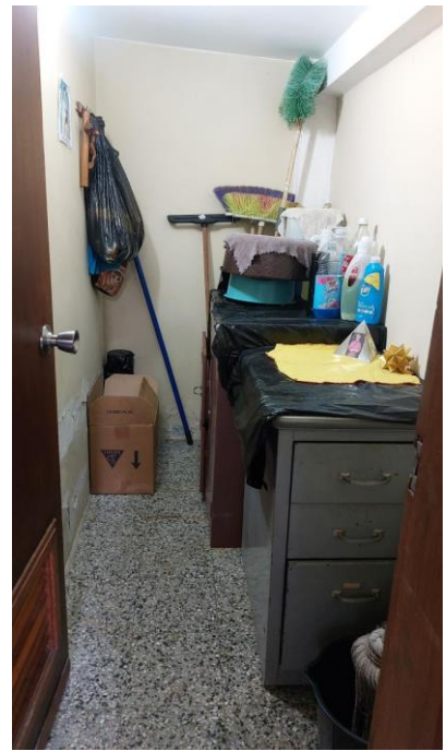
Depósito de Limpieza
